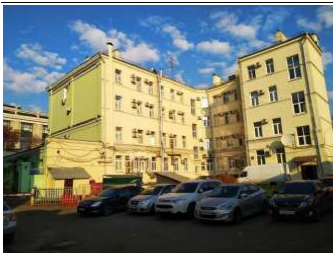
Фотография 3.1. Внешний вид здания
