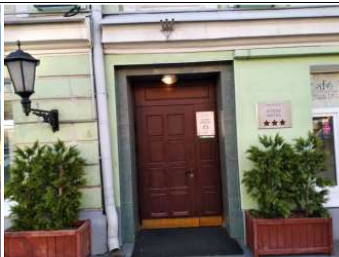
Фотография 3.2. Внешний вид здания
