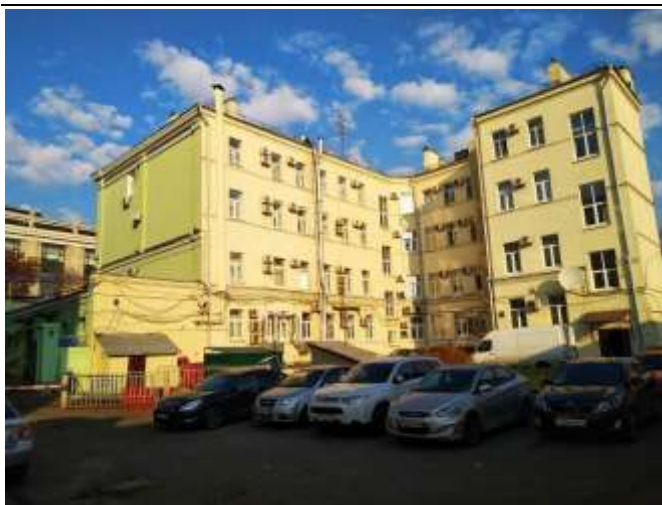
Фотография 3.1. Внешний вид здания
