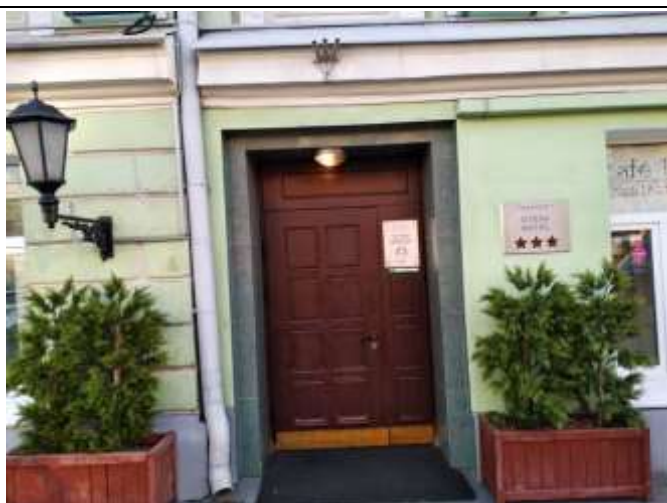
Фотография 3.2. Внешний вид здания
