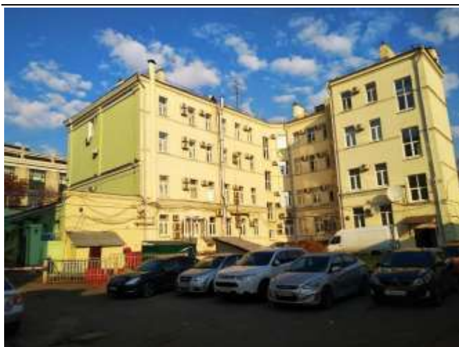
Фотография 3.1. Внешний вид здания
